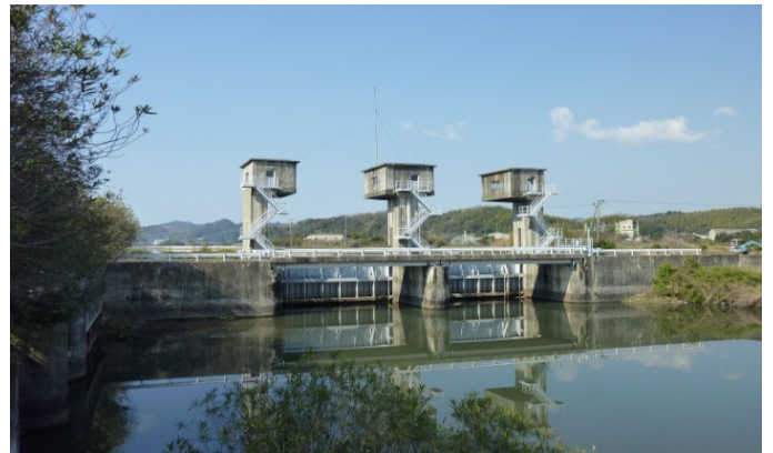
大内川排水機場
