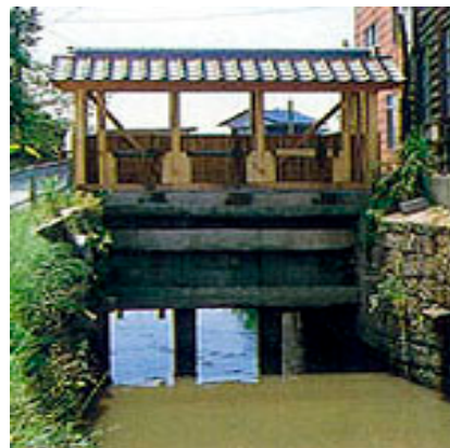
土手町南蛮樋
