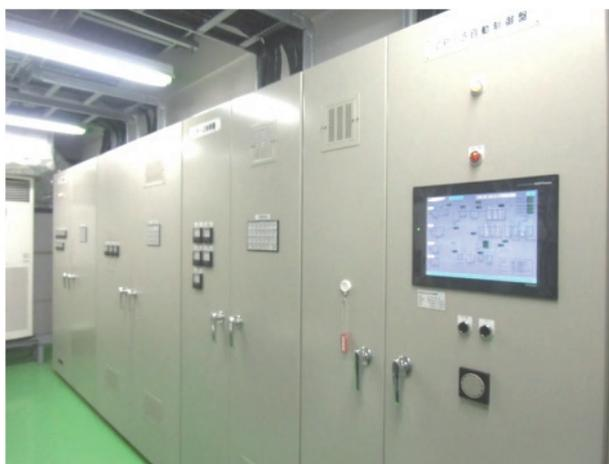
写真5) 水質監視及び排水処理監視システム
