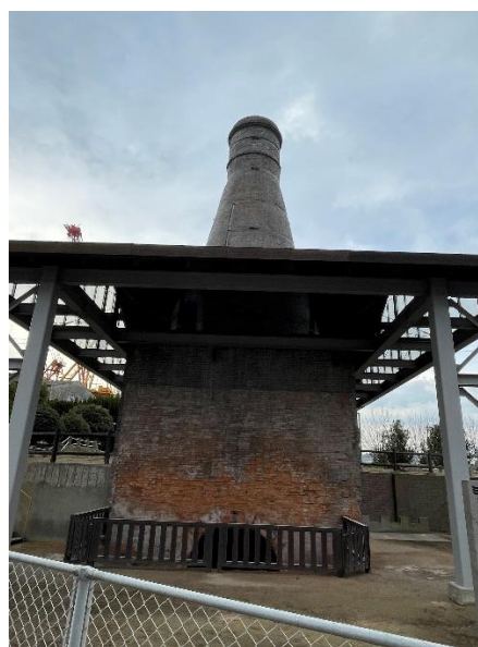
写真 旧小野田セメント徳利窯 (国指定重要文化財)
