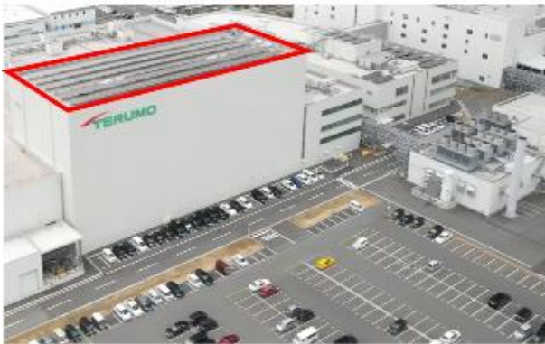
写真3) 倉庫棟屋上 太陽光発電導入
