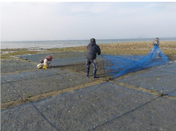
底質改善のための被覆網設置
